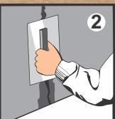
Выровняйте основание. Впадины, трещины и неровности до 15 мм выровняйте kleem для плитки БОЛАРС серии «ОБЪЕКТ», свыше 15 мм – штукатурными составами БОЛАРС.
