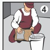
Для подготовки раствора залейте водопроводную воду комнатной температуры в чистую ёмкость из расчёта 4,0 - 5,0 л воды на 1 мешок (25кг).
